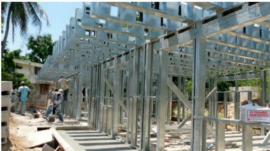
RENAFAM Frauenbildungswerk – erdbebenprobierte Leichtmetallstruktur für das Erdgeschoss
